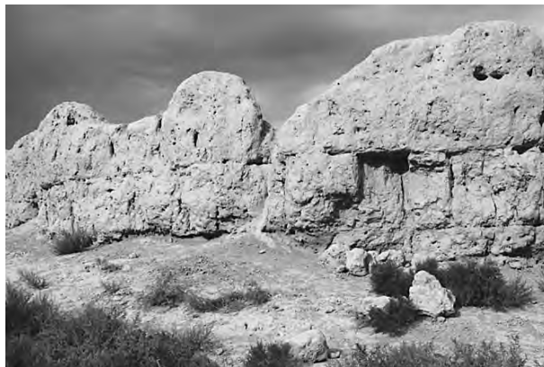
Рис. 3. Пахсовые кладки внешней стены городища Джанкент.
